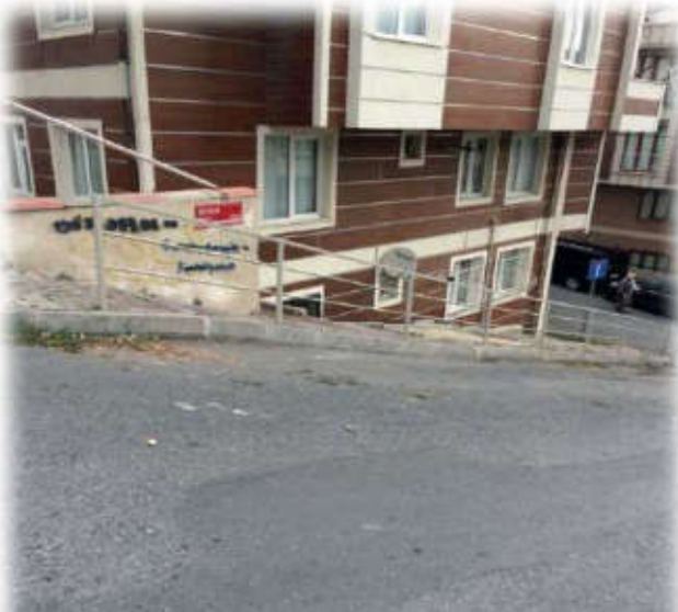
Korkuluk İmalat-Montaj Çalışması
