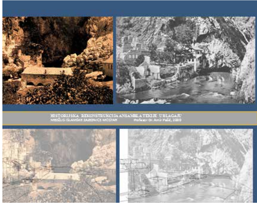
Res. 14. Eski Resimlerdeki izlerin takibi ile Restitüsyona altlık hazırlanması ( Amir Paşiç'ten)
