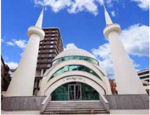
Çifte Minare Camii
